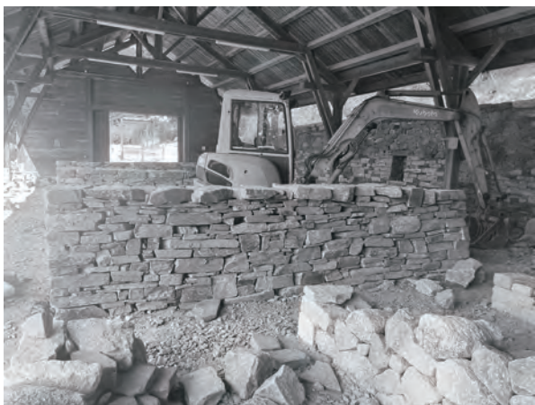
図7 学校敷地内で講習生が習作した乾式石積み壁
