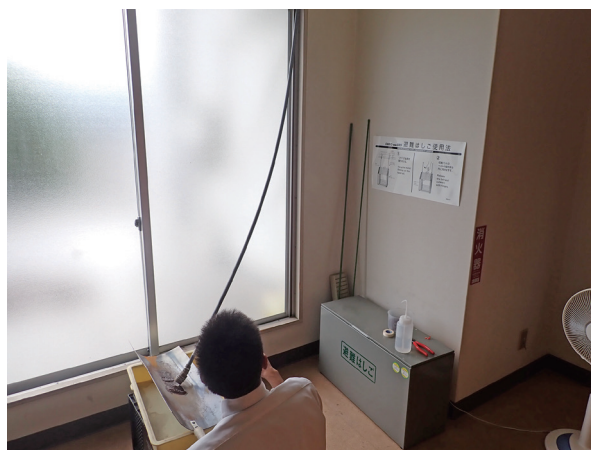
図8. 塩化ビニルパイプを用いた研磨の様子
