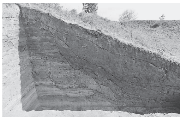
調査時 (2017) 断面：北から
